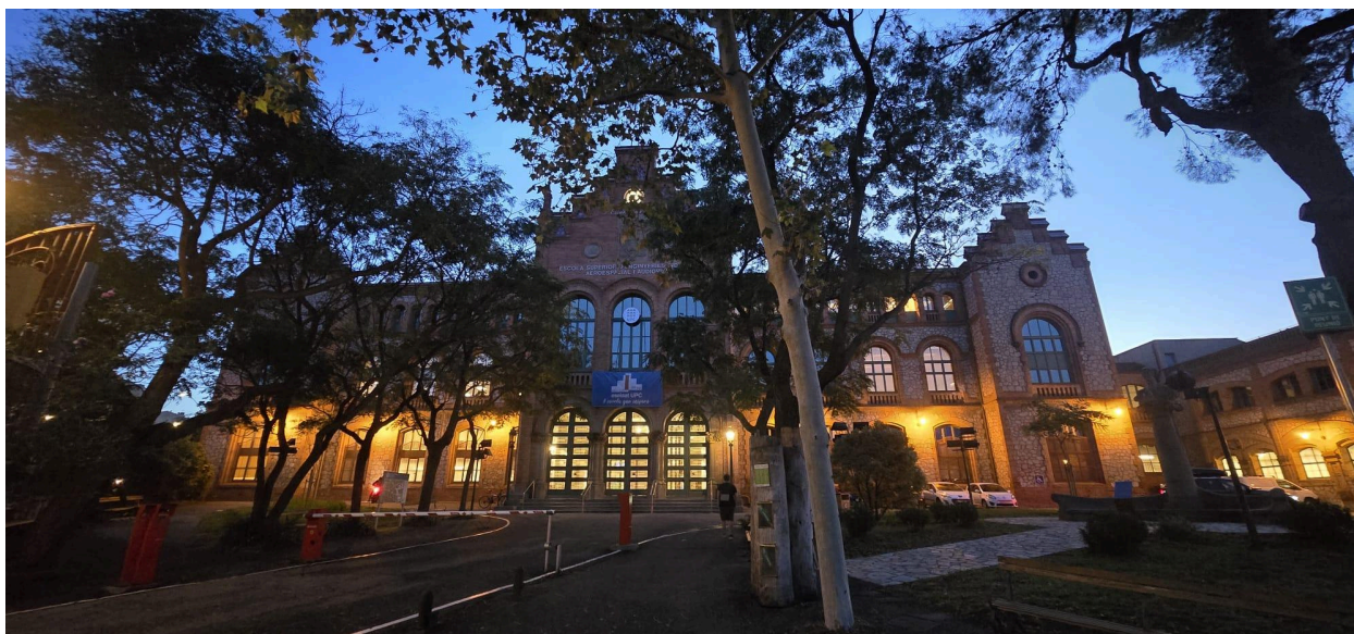
Fotografía 1. Fachada del edificio TR-1.
