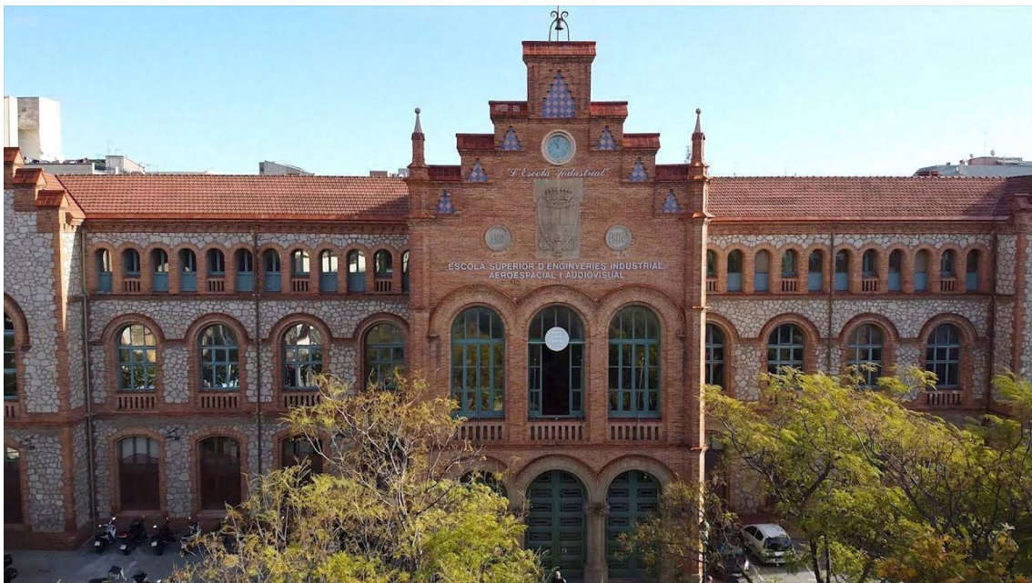
Fotografía 1. Fachada del edificio TR-1.
