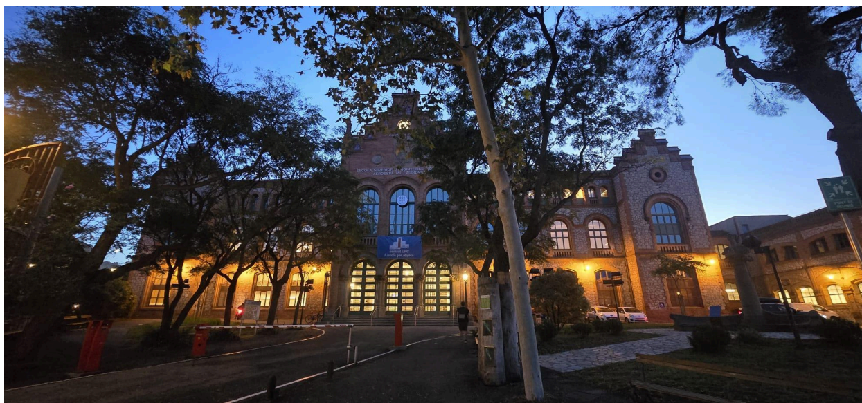
Fotografia 1. Façana de l'edifici TR-1.
