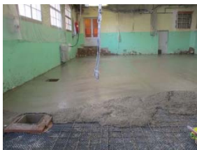
TR3 Rehabilitació d'espai per allotjar una impressora 3D.
