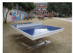
TR45 Instal·lació de taula de ping-pong.
