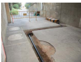
TR5 Substitució canonada general xarxa d'aigua.
