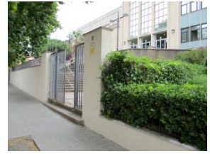
TR5 Pintura del mur exterior.
