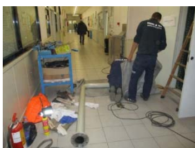
TR4 Reparació canonada contra incendis
