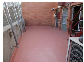
TR7 Reparació de la Terrassa.
