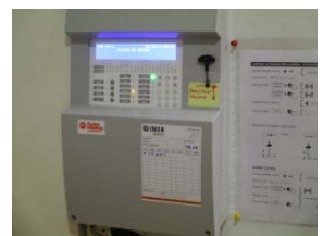
TR11 Nova instal·lació detecció d'incendis PIU.
