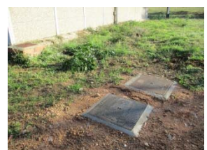
IPCT Nova arqueta per claus de pas de la xarxa d'aigua.
